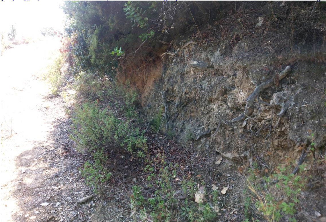
Φωτο Π.5: Νότια Έκταση . Άποψη του υπερκείμενου εδαφοποιημένου μανδύα αποσάθρωσης. Υποκείμενα αυτού διακρίνεται ισχυρά αποσαθρωμένη και αποδομημένη βραχομάζα γνευσιακής σύστασης.
