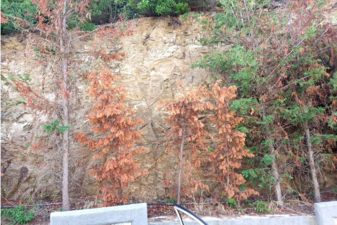
Φωτο Π.33: Βόρεια Έκταση . Άποψη του ελαφρώς αποσαθρωμένου βραχώδους υποβάθρου, στη νοτιοανατολική πλευρά της εξεταζόμενης περιοχής. Διακρίνονται οι διακλάσεις της βραχομάζας.
