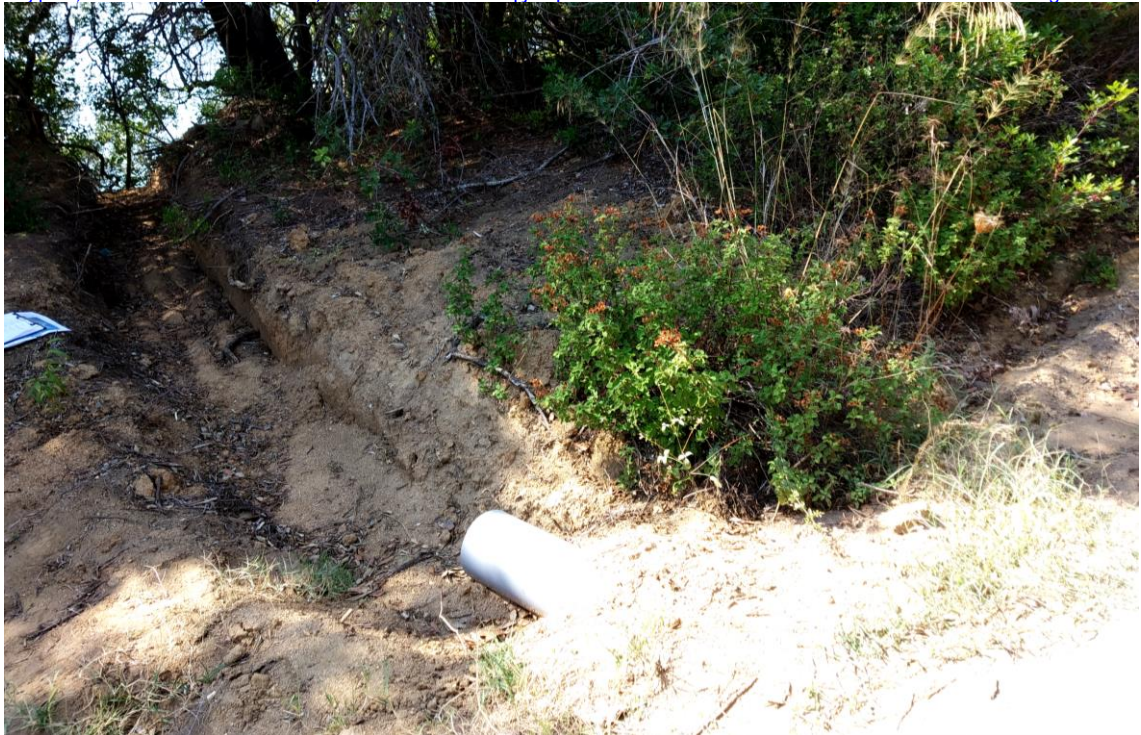
Φωτο Π.19: Βόρεια Έκταση. Άποψη του εδαφικού μανδύα αποσάθρωσης. Διακρίνεται τεχνητό κανάλι, με αγωγό για την αποστράγγιση των ομβρίων υδάτων.
