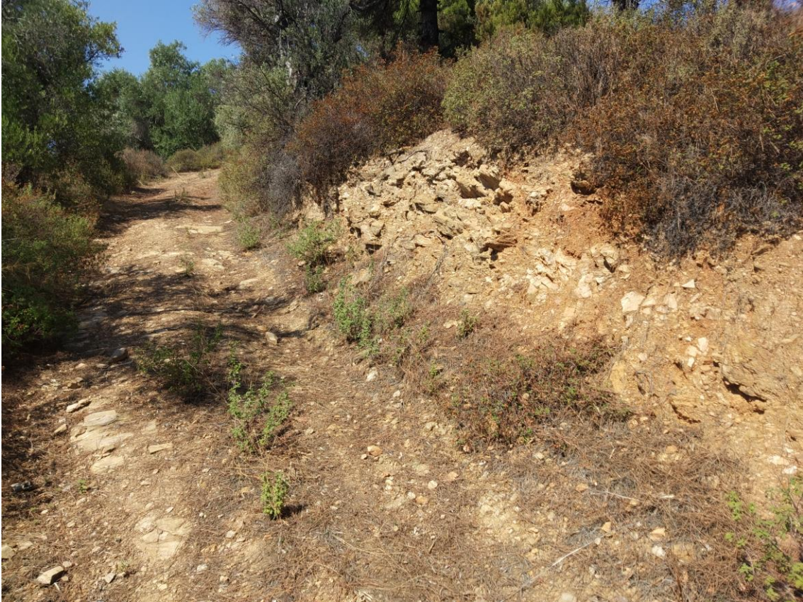
Φωτο Π.3: Νότια Έκταση. Άποψη του ισχυρά αποσαθρωμένου βραχώδους γνευσιακής σύστασης υποβάθρου, με μικρού πάχους υπερκείμενο εδαφικό μανδύα αποσάθρωσης.
