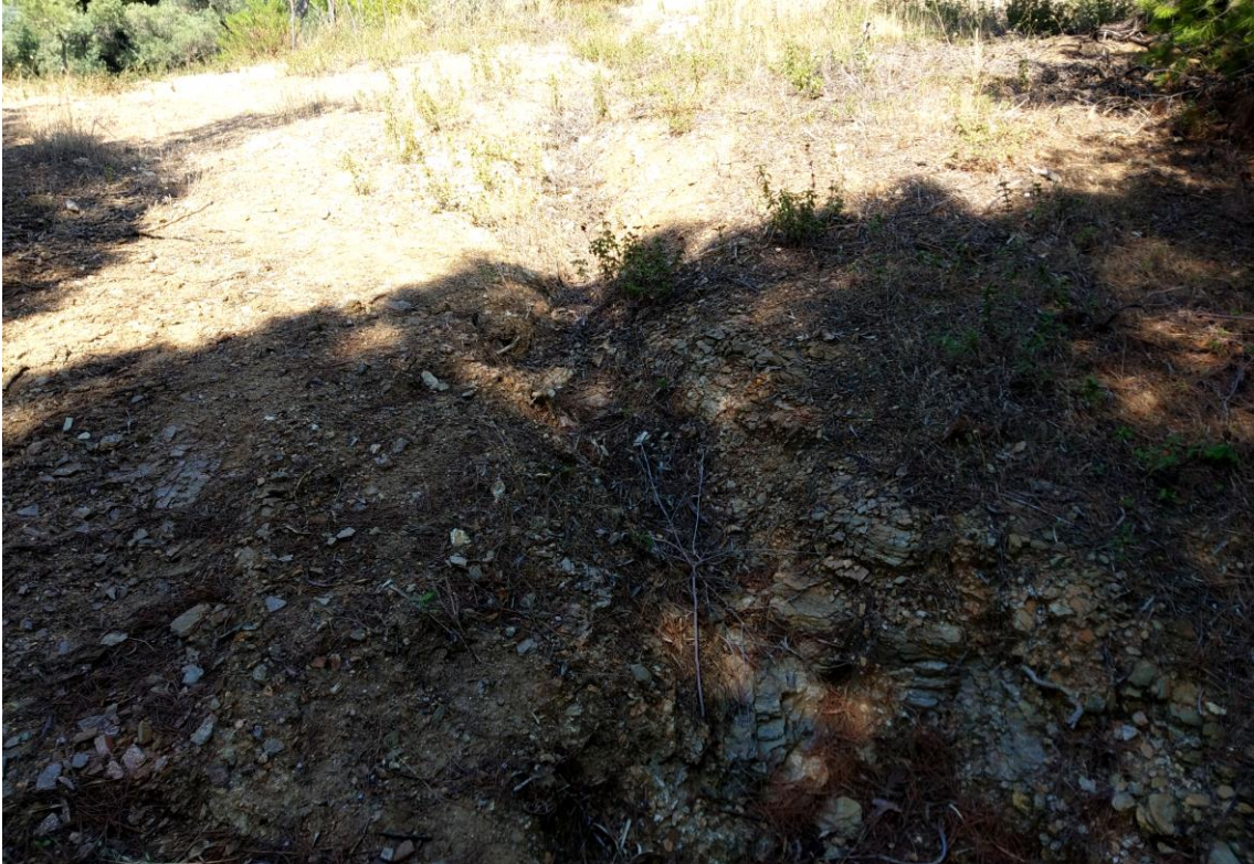
Φωτο Π.23: Βόρεια Έκταση. Άποψη της μετρίως αποσαθρωμένης βραχομάζας γνευσιακής σύστασης, που εντοπίζεται στο κεντρικό τμήμα της εξεταζόμενης έκτασης. Διακρίνεται ελάχιστη επιφανειακή διάβρωση, αποτέλεσμα της επιλεκτικής απορροής των ομβρίων υδάτων
