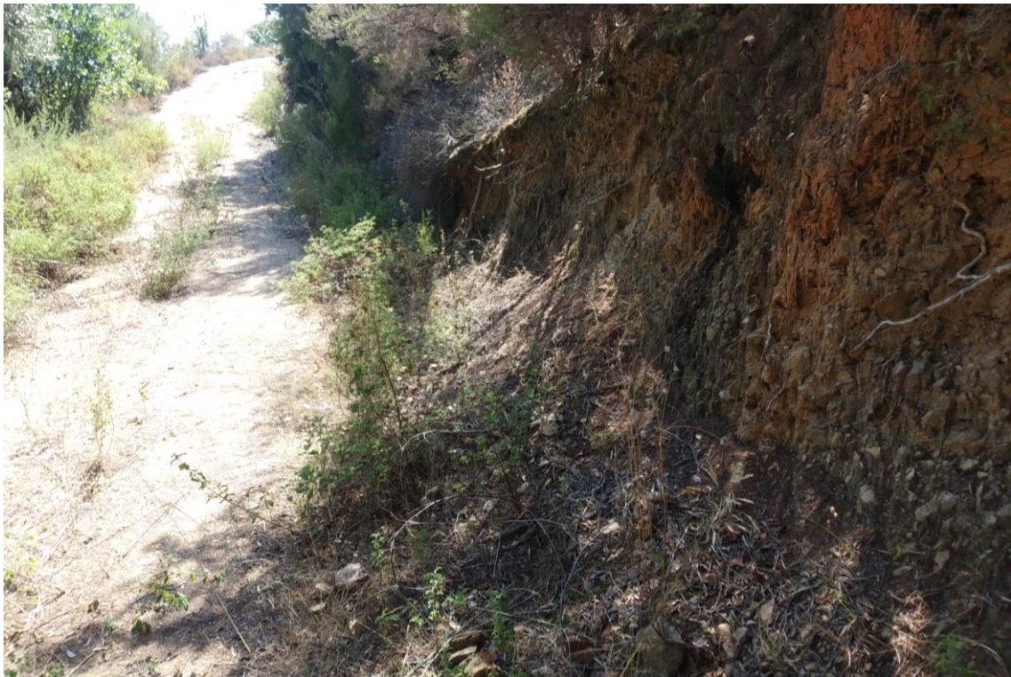
Φωτο Π.6: Νότια Έκταση . Άποψη του υπερκείμενου εδαφοποιημένου μανδύα αποσάθρωσης. Υποκείμενα αυτού εντοπίζεται ισχυρά αποσαθρωμένη και αποδομημένη βραχομάζα γνευσιακής σύστασης.
