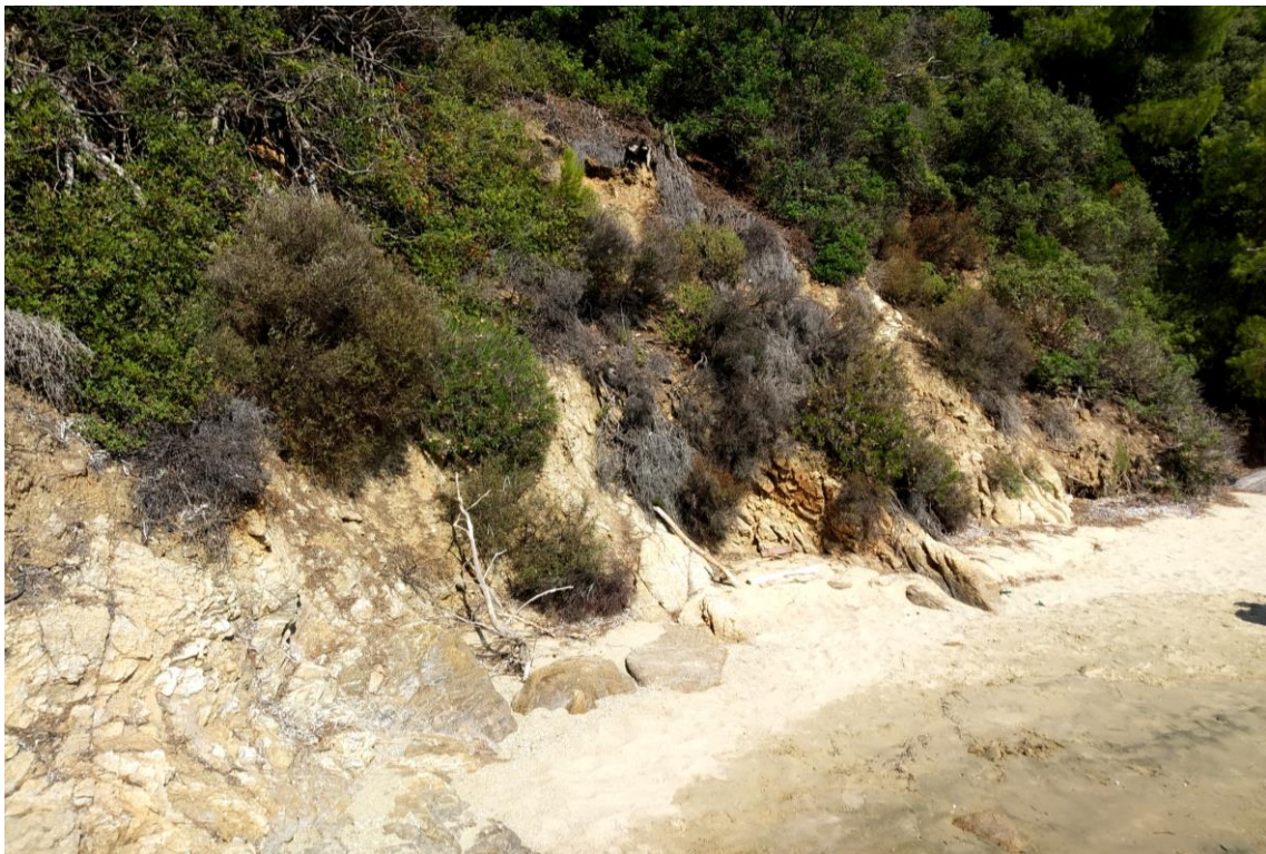
Φωτο Π.28: Βόρεια Έκταση . Άποψη του βραχώδους πρσανούς που αναπτύσσεται δυτικώς της εξεταζόμενης έκτασης. Η βραχομάζα εντοπίζεται ελαφρώς αποσαθρωμένη, δίχως διακριτές ζώνες αστοχιών.
