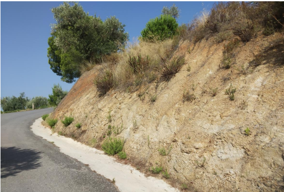
Φωτο Π.34: Βόρεια Έκταση . Άποψη του μετρίως αποσαθρωμένου βραχώδους υποβάθρου, στη νοτιοανατολική πλευρά της εξεταζόμενης περιοχής. Διακρίνονται κατά θέσεις, οι διακλάσεις της βραχομάζας.
