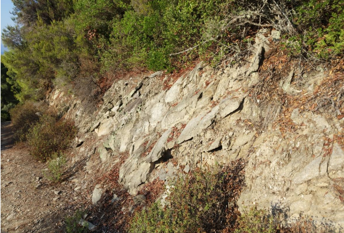
Φωτο Π.7: Νότια Έκταση . Άποψη της ελαφρώς αποσαθρωμένης βραχομάζας γνευσιακής σύστασης, που εντοπίζεται ΒΑ της εξεταζόμενης έκτασης, στον υφιστάμενο χωματόδρομο πρόσβασης. Διακρίνεται η σχιστότητα.
