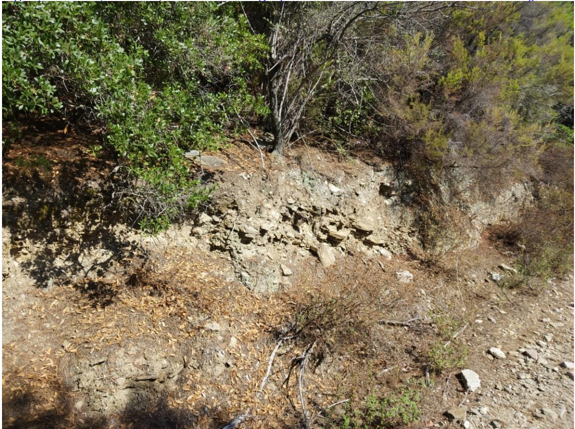
Φωτο Π.11: Νότια Έκταση. Άποψη της ελαφρώς αποσαθρωμένης βραχομάζας γνευσιακής σύστασης, που εντοπίζεται ΒΑ της εξεταζόμενης έκτασης, στον υφιστάμενο χωματόδρομο πρόσβασης. Διακρίνεται η σχιστότητα και ο μικρού πάχους υπερκείμενος μανδύας αποσάθρωσης.
