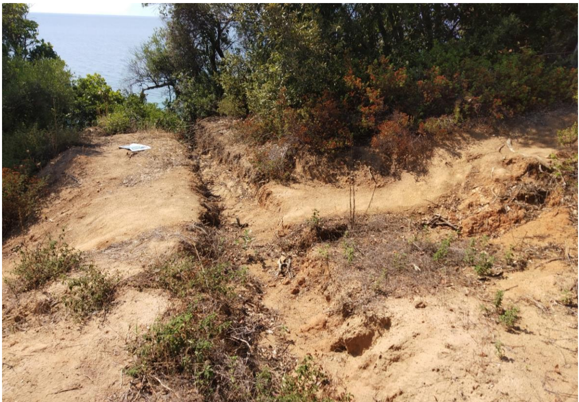
Φωτο Π.18: Βόρεια Έκταση. Άποψη του εδαφικού μανδύα αποσάθρωσης. Διακρίνεται τεχνητά διανοιγμένο κανάλι για την αποστράγγιση των ομβρίων υδάτων.
