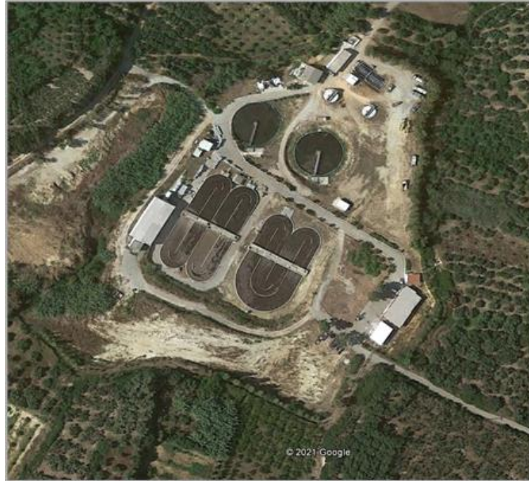
Εικόνα 12: ΕΕΛ Δ.Ε.Υ.Α.Β.Α., (Πηγή: ΣΜΠΕ μελέτης ΕΣΧΑΣΕ COSTA NOPIA)
