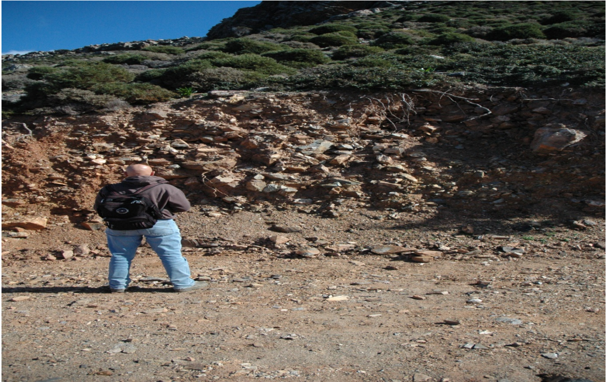
Φωτ. 83 – ΣΠ 78: Άποψη των πλευρικών κορημάτων των φυλλιτών – χαλαζιτών (Q.sc) σε πρηνές εκσκαφής επί του χωματόδρομου. Πάχος > 2 m.
