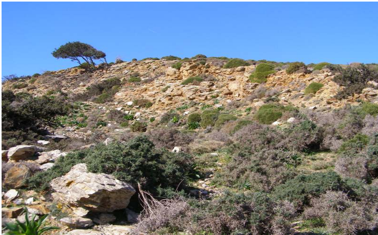
Φωτ. 34 – ΣΠ 40 : Χαρακτηριστική εμφάνιση, μέτρια αποσαθρωμένων επιφανειακά, σχηματισμών της σειράς των φυλλιτών - χαλαζιτών.
