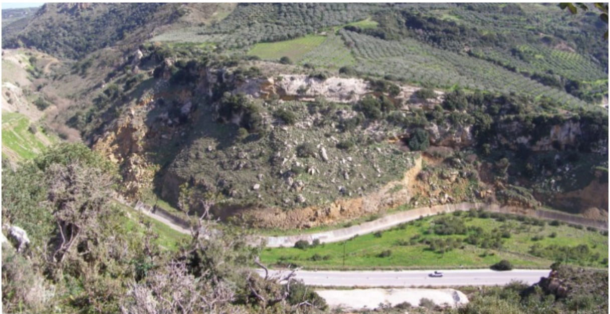
Φωτ. 46– ΣΠ 49: Άποψη εκδηλωμένων κατολισθήσεων σε νεογενείς σχηματισμούς νότια της περιοχής του έργου. Περιοχή νότια του ΒΟΑΚ.
