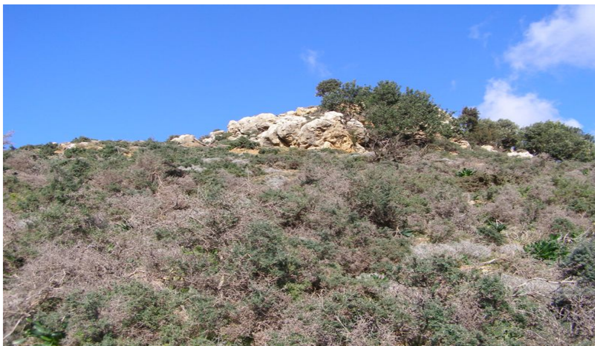
Φωτ. 21 – ΣΠ 26: Άποψη επικρεμάμενων μαργαϊκών ψηφιδοπαγών (Mi) - μαργαϊκών ασβεστόλιθων (Μκ).
