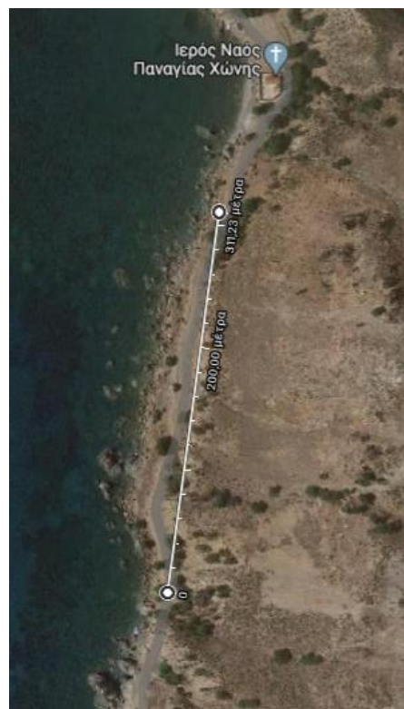
Εικόνα 8-8: Περιοχή παραλιακής οδού πρόσβασης που απαιτεί μέτρα αντιστήριξης του ορύγματος
