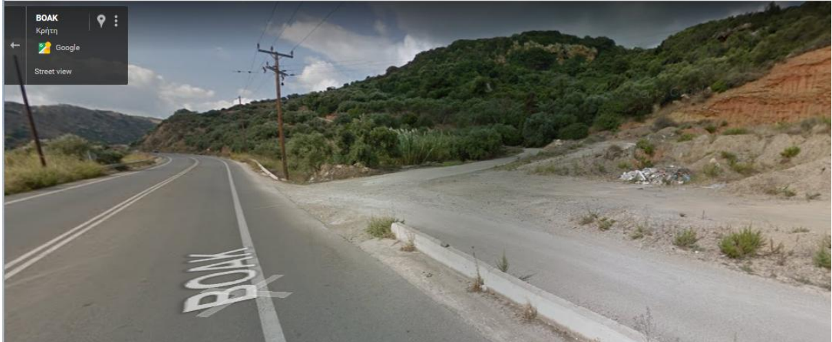
Εικόνα 5-5: Ισόπεδη σύνδεση του Β.Ο.Α.Κ., στην κατεύθυνση από Χανιά προς Κίσαμο
