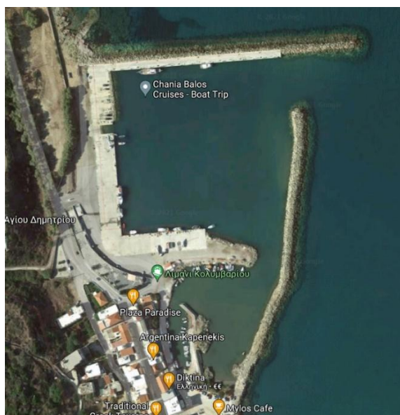
Εικόνα 4-6: Λιμάνι Κολυμβαρίου (Πηγή: GoogleMaps)
