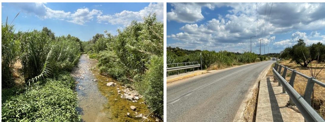
Εικόνα 23 Κλάδος ρέματος Ραφήνας (αριστερά) και υπερκείμενη γέφυρα επί της ΕΟ Σπάτων – Πικερμίου
