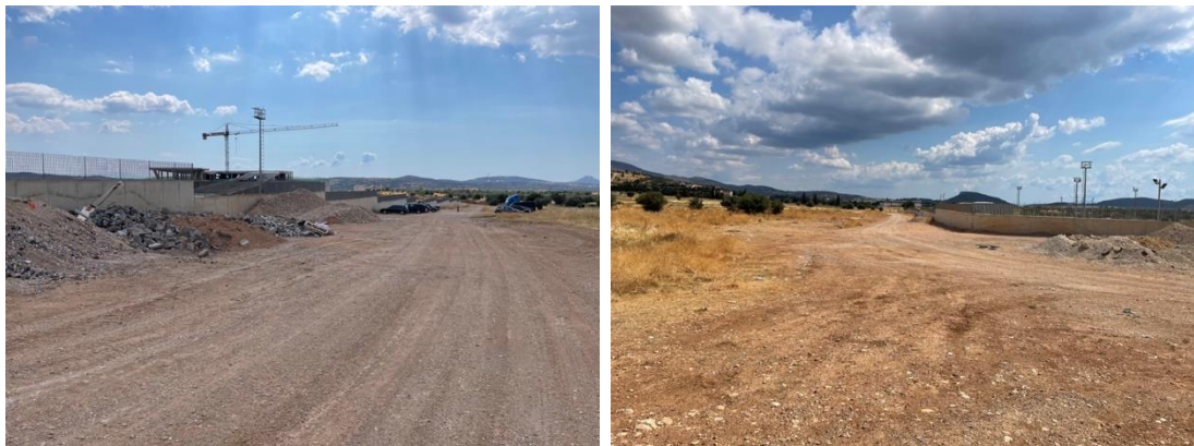
Εικόνα 15 Υπό κατασκευή εγκαταστάσεις ΕΛΠΕΝ (αριστερά) και δρόμος που χωρίζει το ακίνητο της Microsoft από την ΕΛΠΕΝ. β) δρόμος εντός ΒΙΠΑ δυτικά της ΕΛΠΕΝ (όμορο με το υπό μελέτη ακίνητο) (δεξιά)
