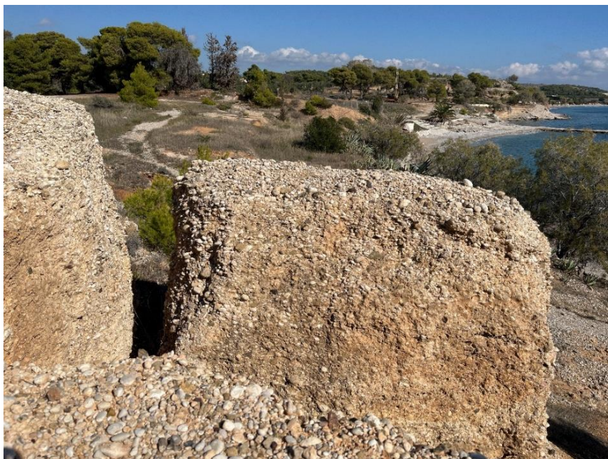
Εικόνα 6.4.4-2: Άποψη ογκόλιθου που έχει αστοχήσει κατά μήκος των παράκτιων πρανών στα ΝΔ τμήματα της περιοχής
