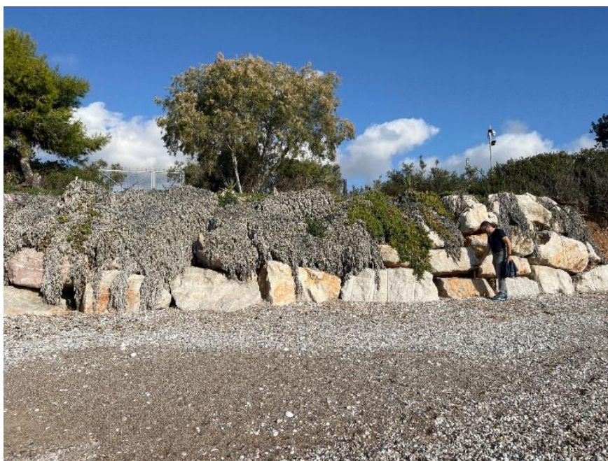
Εικόνα 6.4.4-4: Αντιδιαβρωτικά μέτρα κατά μήκος των πρανών της παράκτιας ζώνης σε παρακείμενη ιδιοκτησία.
