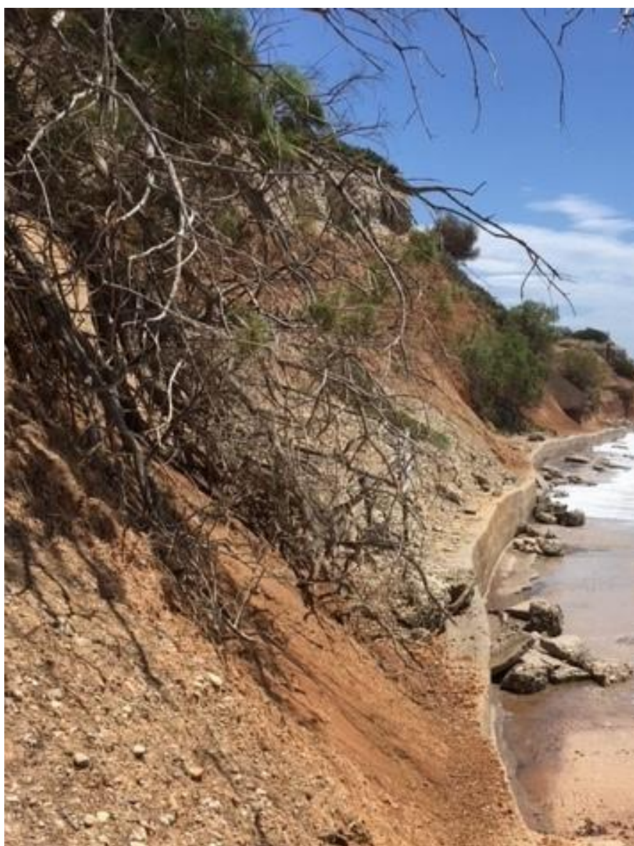
Απότομο πρανές λόφου με προστατευτικό τοιχίο στον πόδα του
